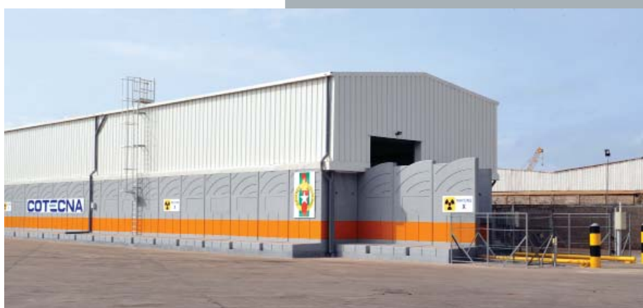
Instalación de escáner de pórtico reubicable
